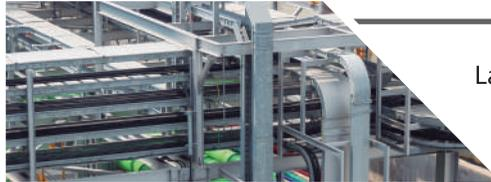
Las múltiples perforaciones permiten la fijación y ventilación de los cables.
